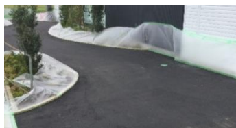
マス킹テープと養生シートで保護 排水溝やマンホールなども丁寧に養生
