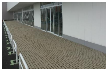
養生シート・マスキングテープ撤去
