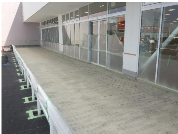
上塗り 1 層目吹付け終了
