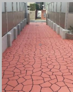
スプレーステンシル工法 施工例
