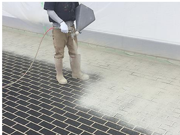
上塗り 1 層目の吹付け
