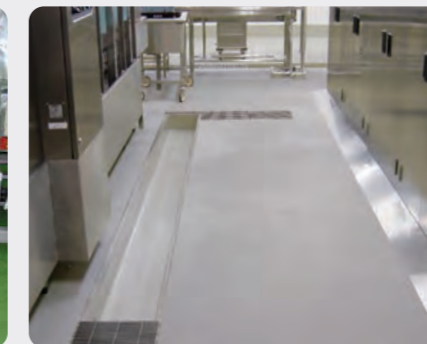
病院厨房施工例(防滑グレー)
