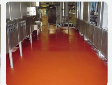
食品工場施工例(防滑レッド)
