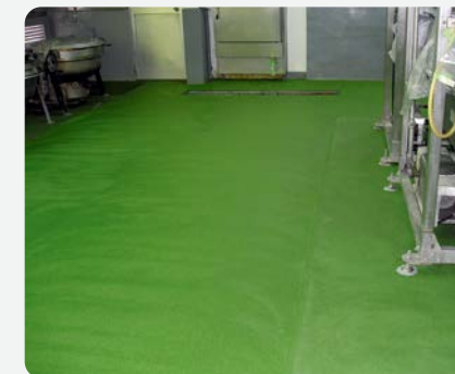
食品工場施工例(防滑グリーン)
