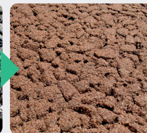
（開粒度アスコン）施工後
