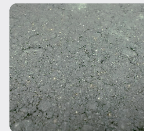
（密粒度アスコン）施工前
