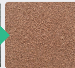
（密粒度アスコン）施工後
