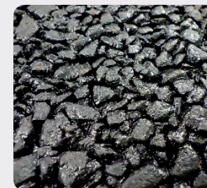
（開粒度アスコン）施工前
